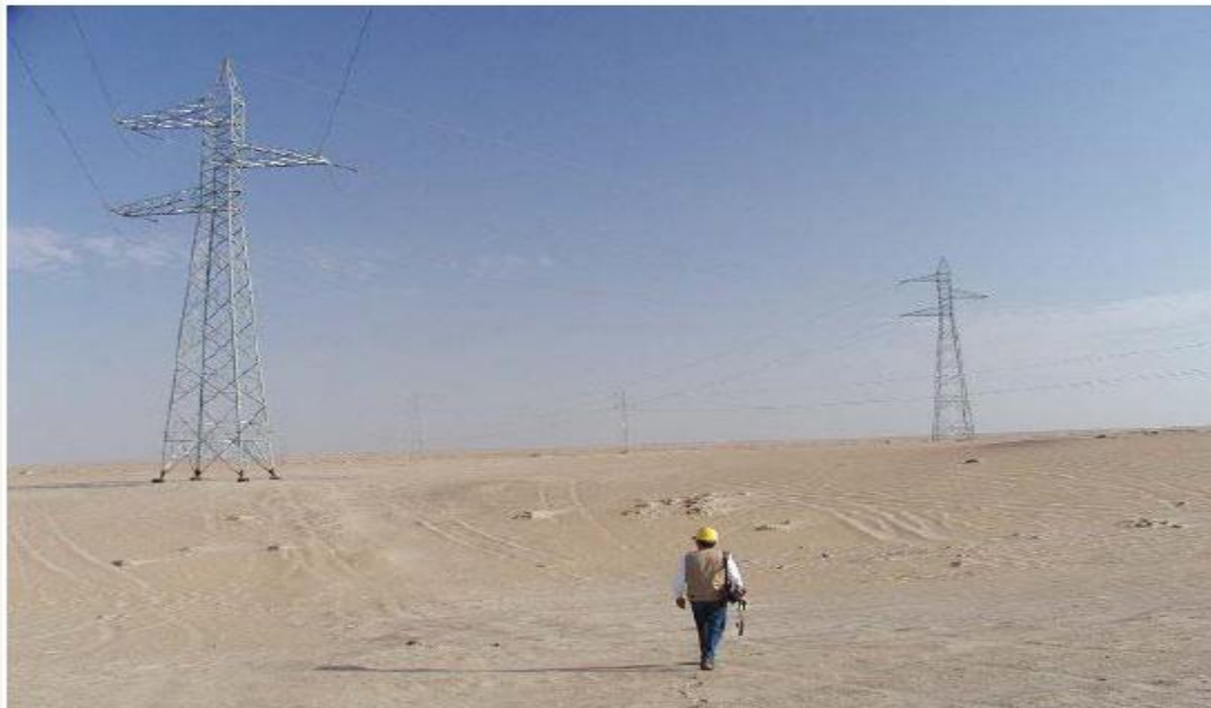
L.T. 220 kV Moquegua – Tacna Sector Los Héroes , Tacna Tacna REDESUR
